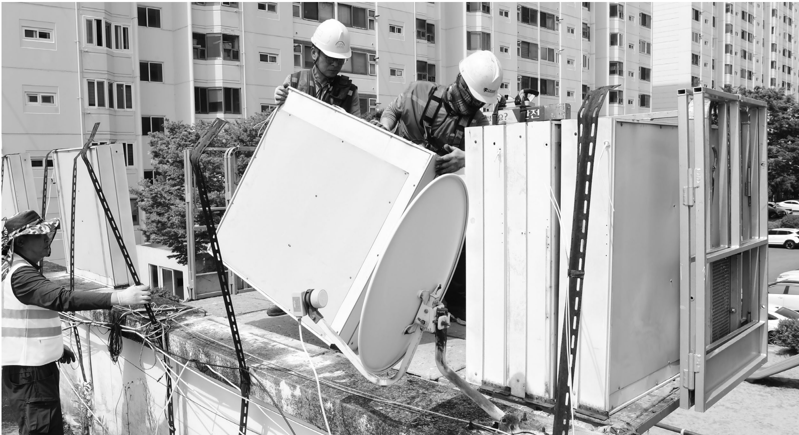
자연재해 예방 노후간판 철거
